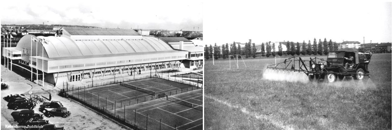
Til venstre: Den nyopførte KB-hal i 1939. Til højre: Stadsgartnerens folk sprøjter mod ukrudt på de store boldbaner mellem Roskildevej og KB-hallen – foto fra 1949. (Frederiksberg Stadsarkivs billedsamling).
