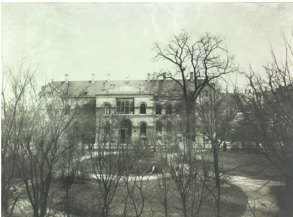
Forsørgelses- og hospitalsvæsenets institutionskompleks nord for Howitzvej påbegyndtes i 1863 og var den første kommunale institution, der allerede fra starten blev omgivet af større haveanlæg. Her ses kompleksets hospitalsbygning med have fra 1885 en vinterdag i år 1900. Komplekset blev opgivet, da institutionen 1903 flyttedes til den meget store grund mellem Nylandsvej og Godthåbsvej vest for Nordre Fasanvej. (Frederiksberg Stadsarkivs billedsamling)
