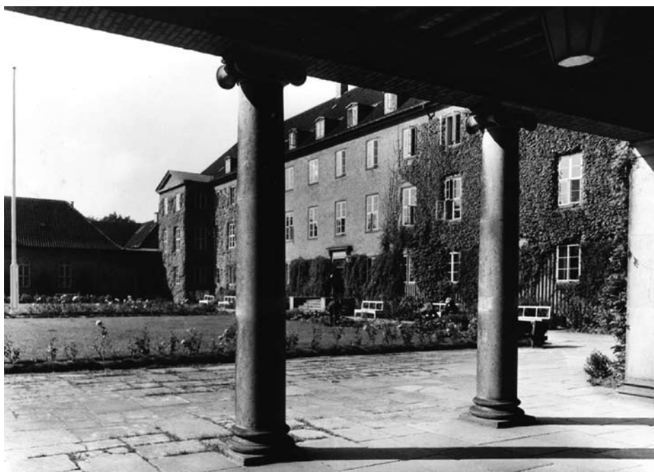
Frederiksberg Kommunes Alderdomshjem, Vestfløj og Kolonnaden.
